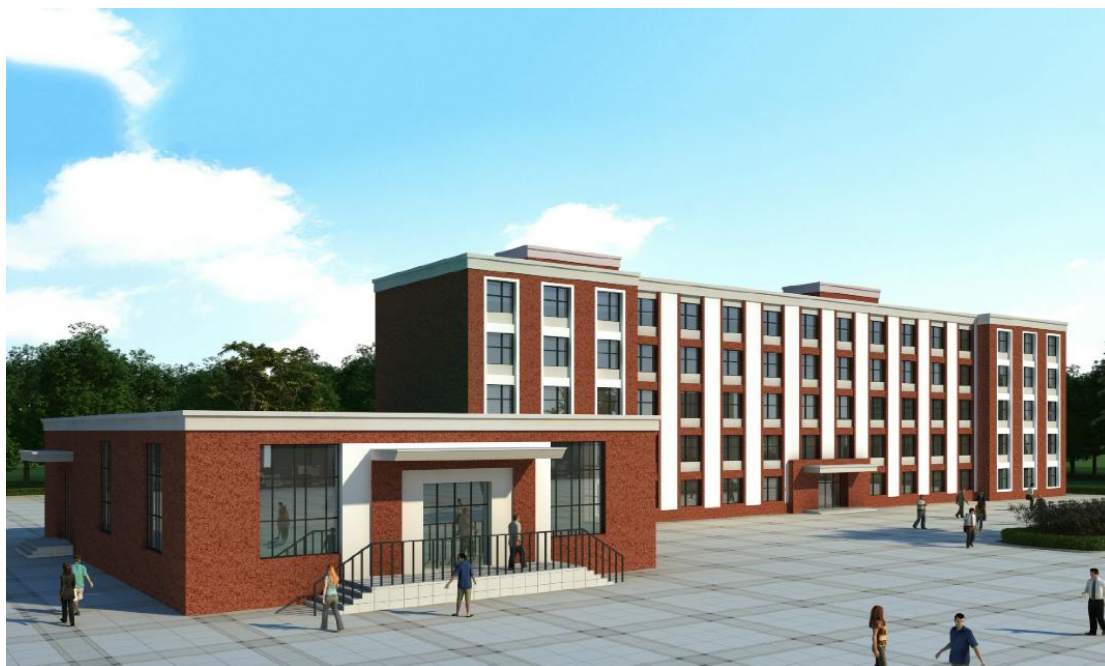
图 10：通榆县职业技术学校新建宿舍楼
